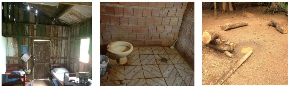
Figura 2: Exemplos de precariedades encontradas no local: (1) casa com estrutura em madeira, (2) falta de revestimento em áreas molhadas, (3) esgoto da cozinha lançado no quintal. *Fonte: Acervo pessoal.*
